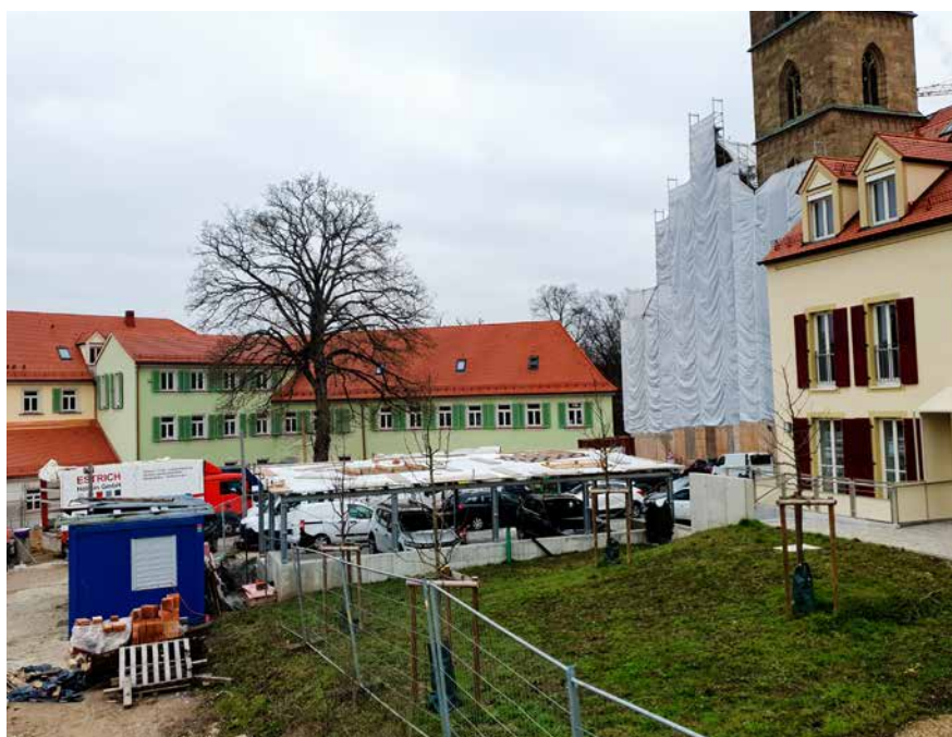
Baustelle Kloster Bamberg
