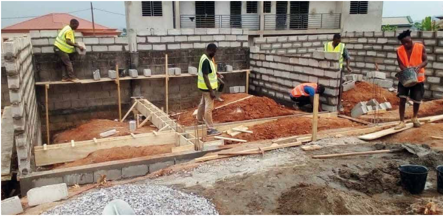
Die ersten Mauern des neuen Kindergartens
